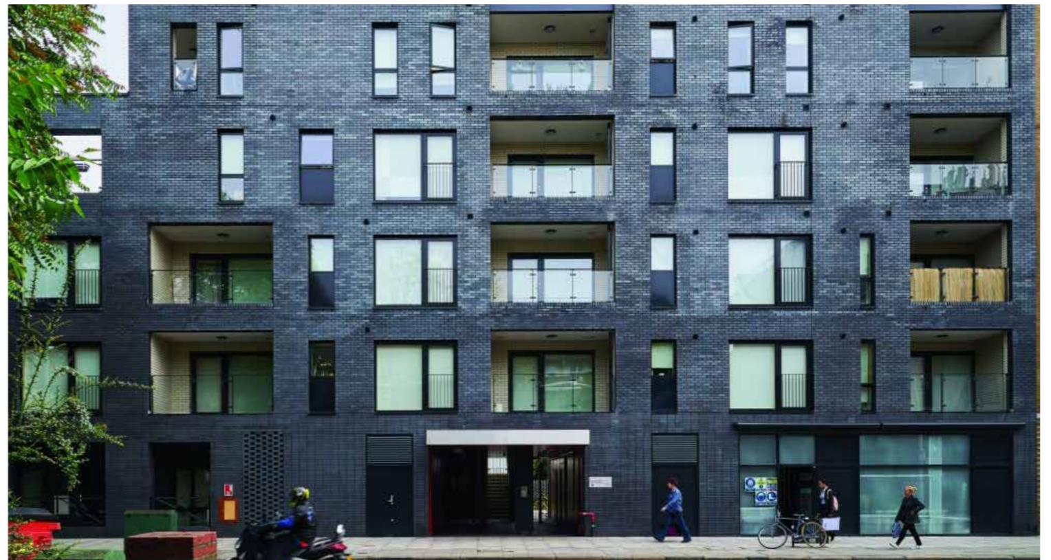
169 Long Lane / Long Lane, SE1
