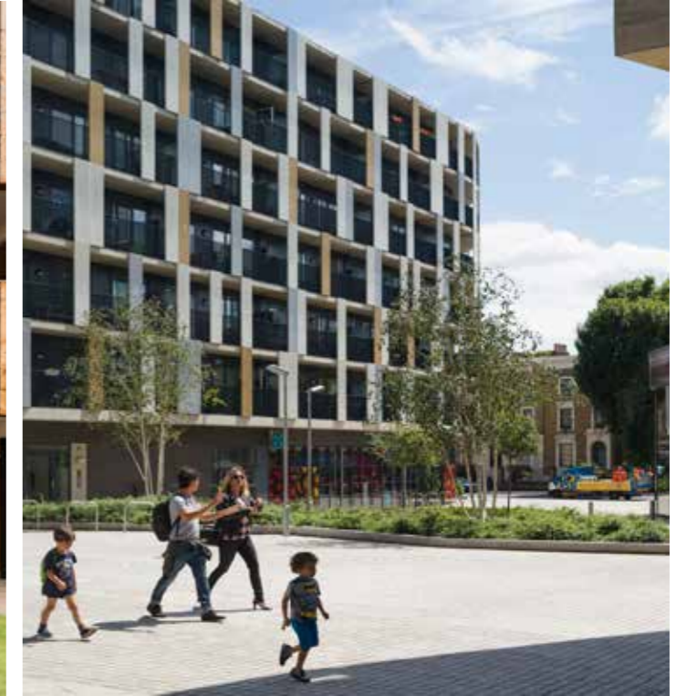
Pembury Circus / Hackney, FBM Architects
