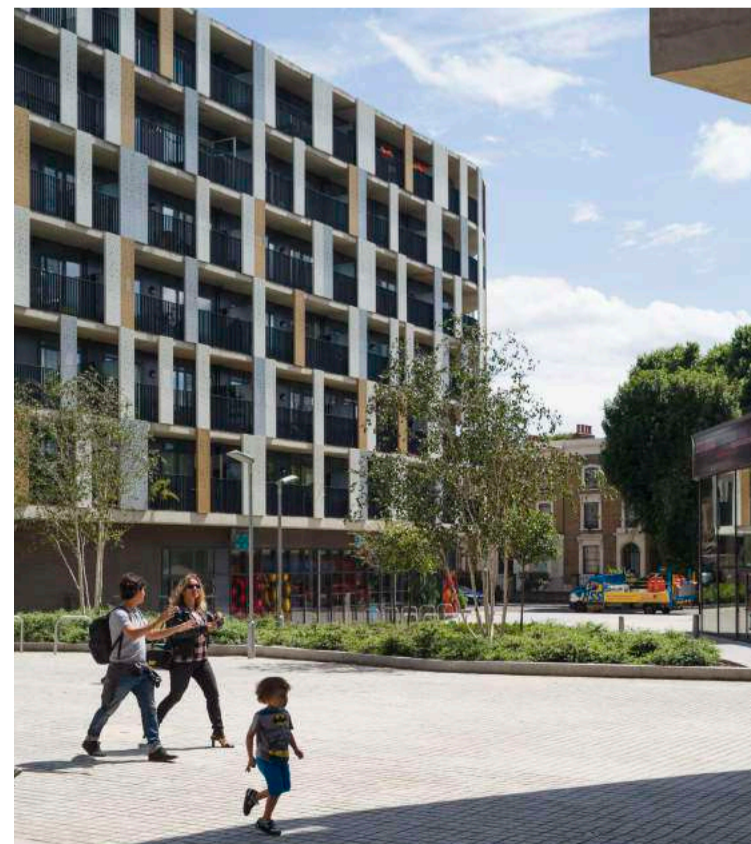
Pembury Circus / Hackney, FBM Architects
