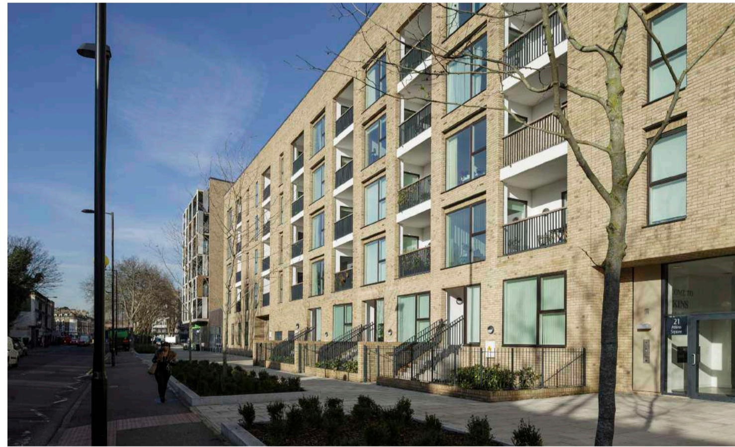
Pembury Circus / Hackney, FBM Architects
